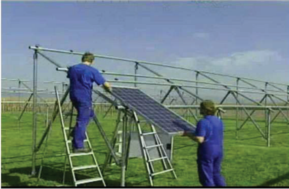
Монтажа на носечка конструкција и PV модули.
