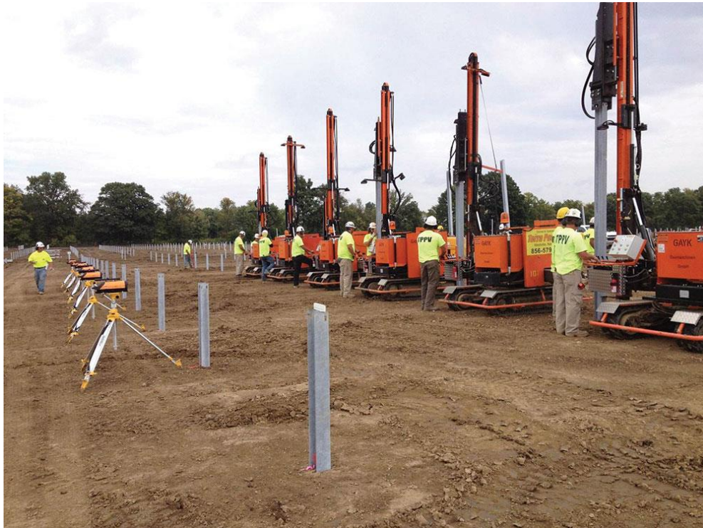
Слика 13. Приказ на машинерија за набивање на столбовите во земја
