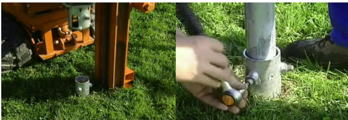
Слика 15. Вкопан клин во земја и поставување на носечката конструкција на него
