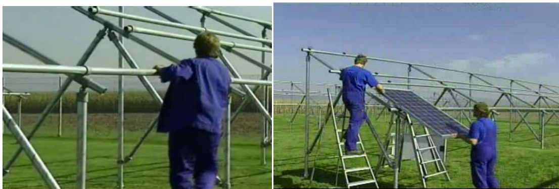
Слика 16. Монтажа на носечка конструкција и PV модули.
